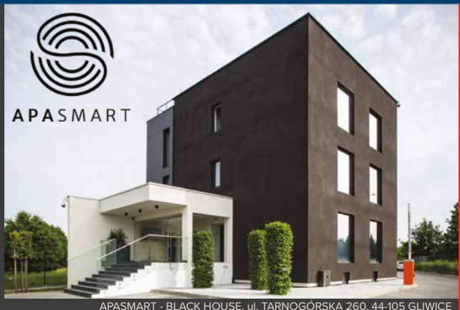
APASMART - BLACK HOUSE, ul. TARNOGÓRSKA 260, 44-105 GLIWICE
